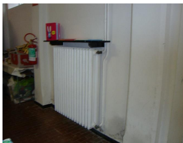
Figura 4.9 – Particola radiatore in alluminio
