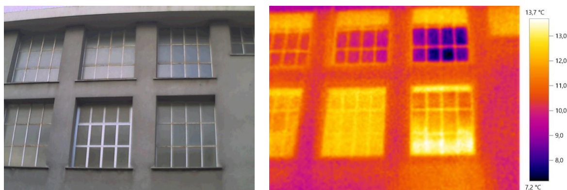
Figura 4.6 – Rilievo termografico dei serramenti del locale Palestra
