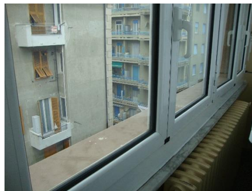
Figura 4.5 - Particolare dei serramenti
