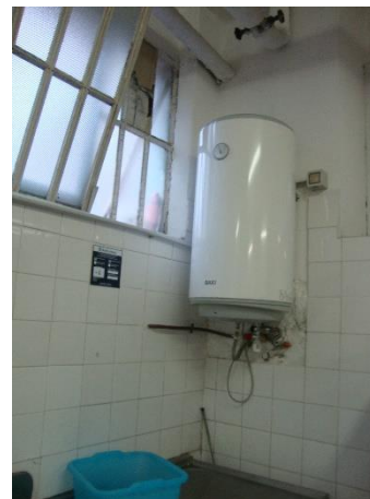
Figura 4.16 - Particolare di un boiler elettrico per la produzione di acqua calda sanitaria
