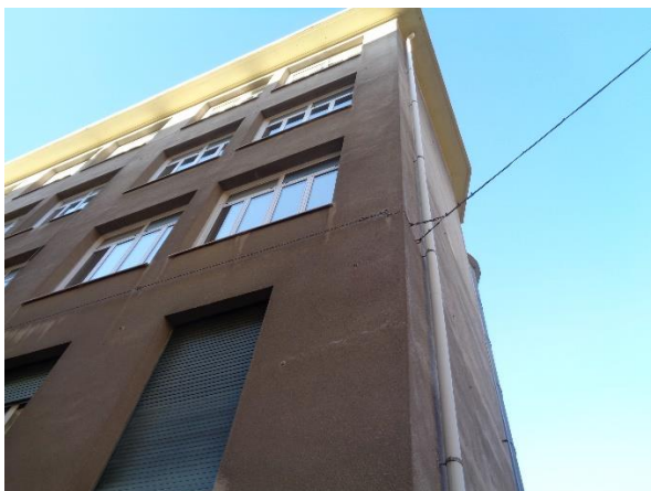
Figura 4.2 - Particolare della porzione di involucro
