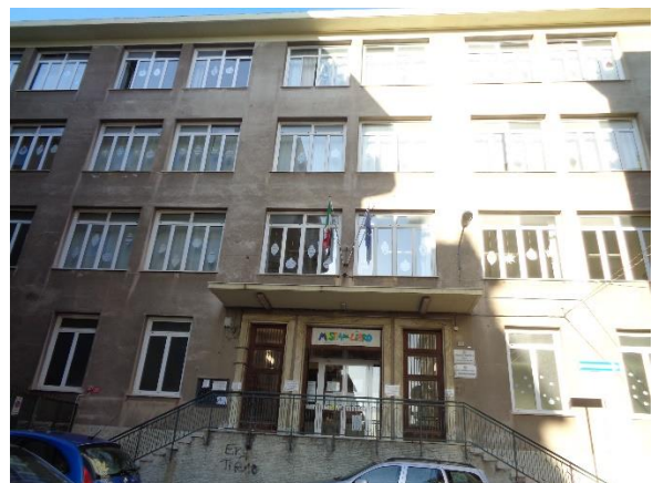
Figura 4.3 - Particolare della facciata Sud - Ovest
