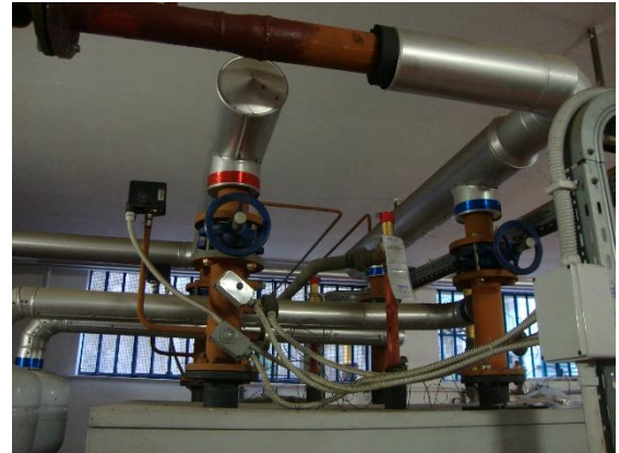
Figura 4.11 – Sonde di temperatura sulla mandata
